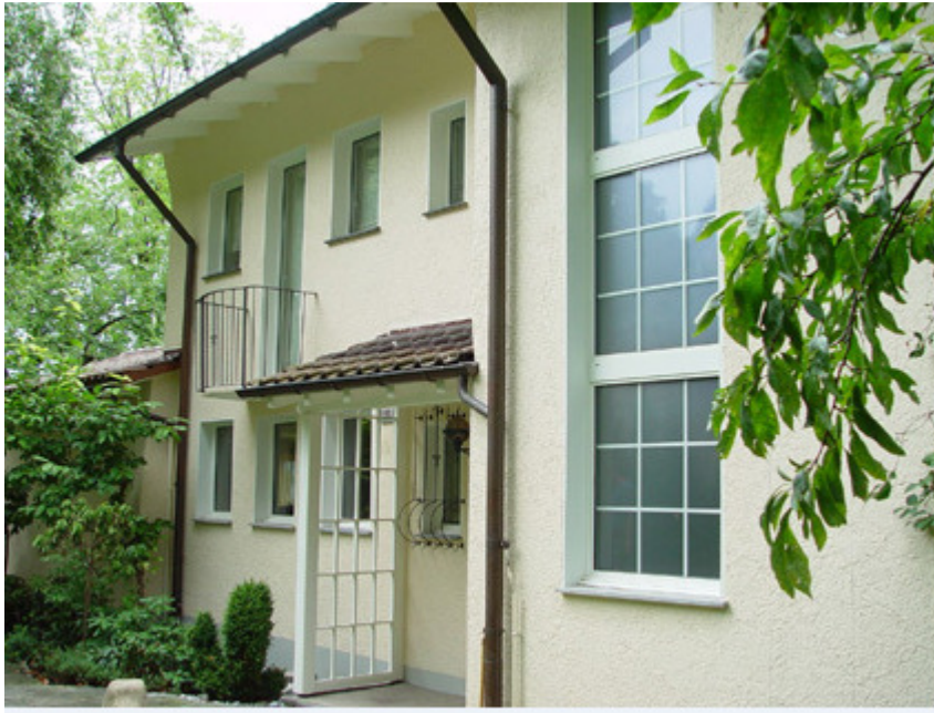
Vordach. Schösslistr. 29, 8044 Zürich (1946)
